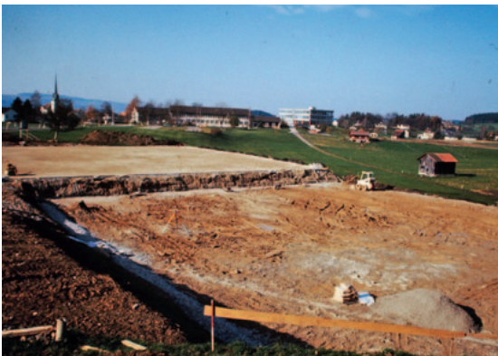
Die Aushubarbeiten begannen bereits 1977 mit dem ersten Spatenstich.
